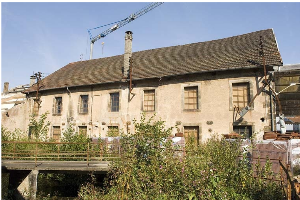
Façade sud de l'atelier de fabrication.
