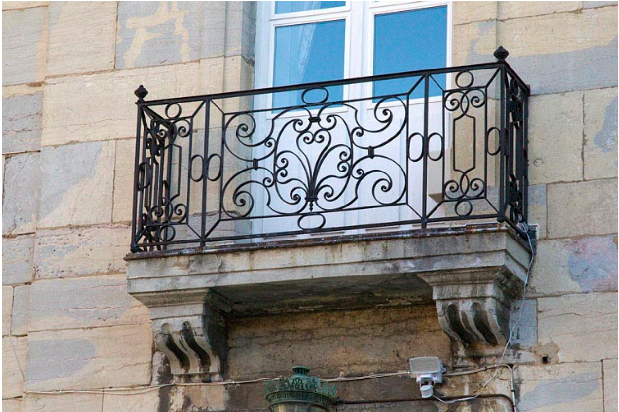
Façade antérieure, partie centrale : détail du balcon.
