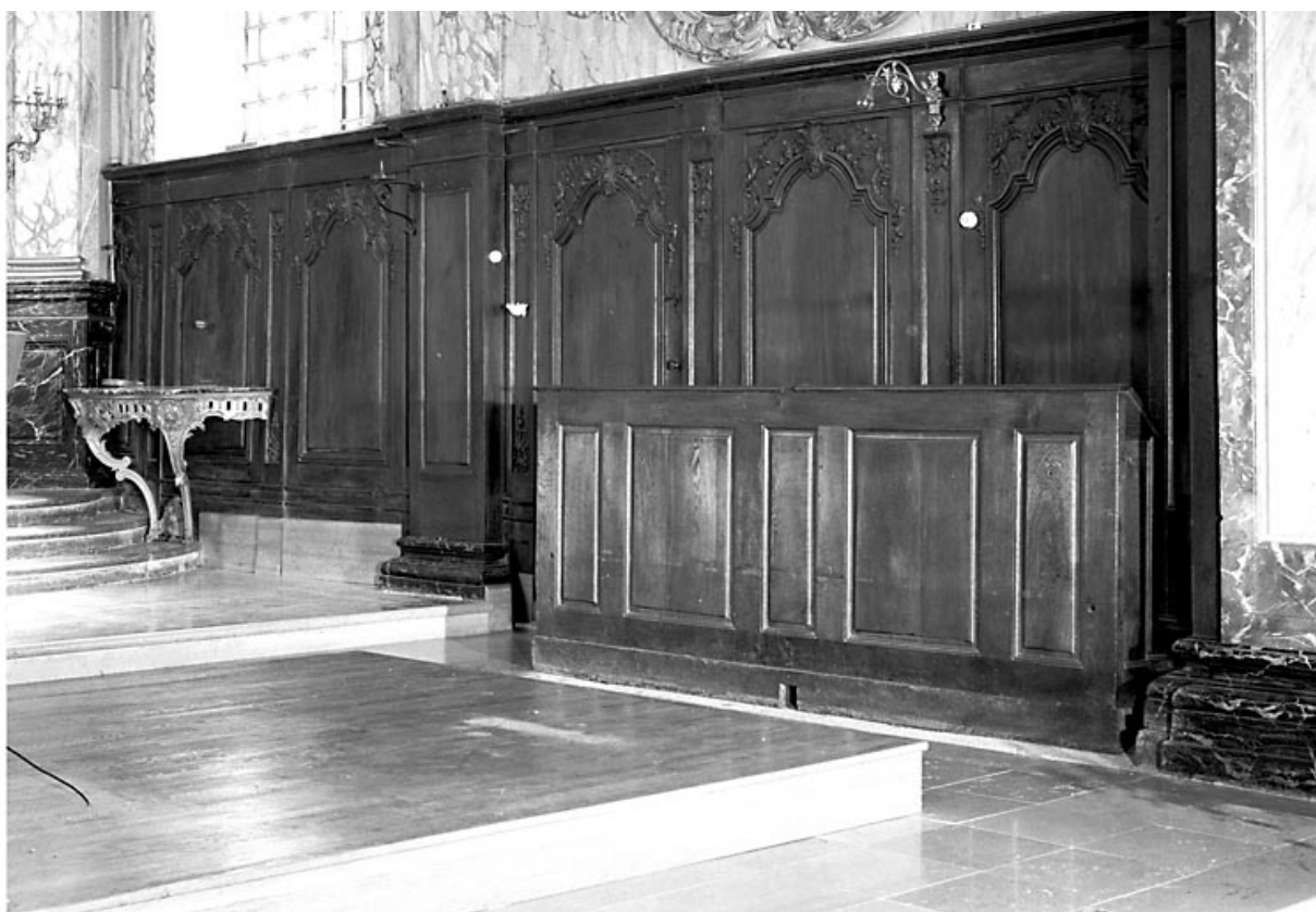
Vue d'ensemble des lambris du mur droit.
