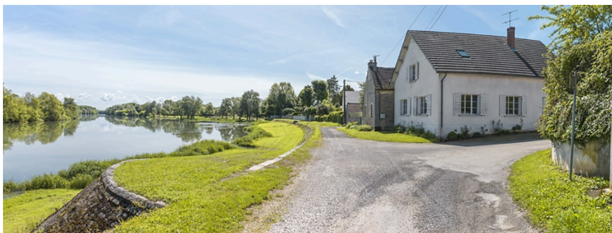
Tête aval de la digue.
