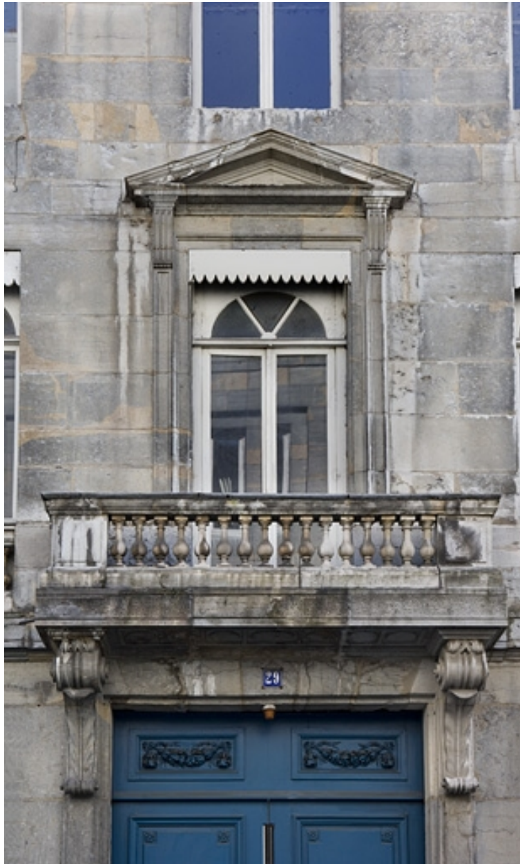
Détail de la baie et du balcon situés au-dessus du portail d'entrée.
