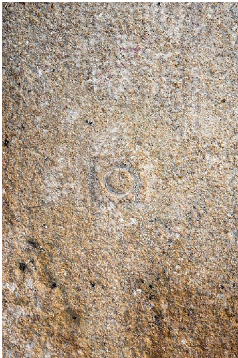
Pierre avec marque de tâcheron dans l'encadrement d'une porte, à l'intérieur de la maison
