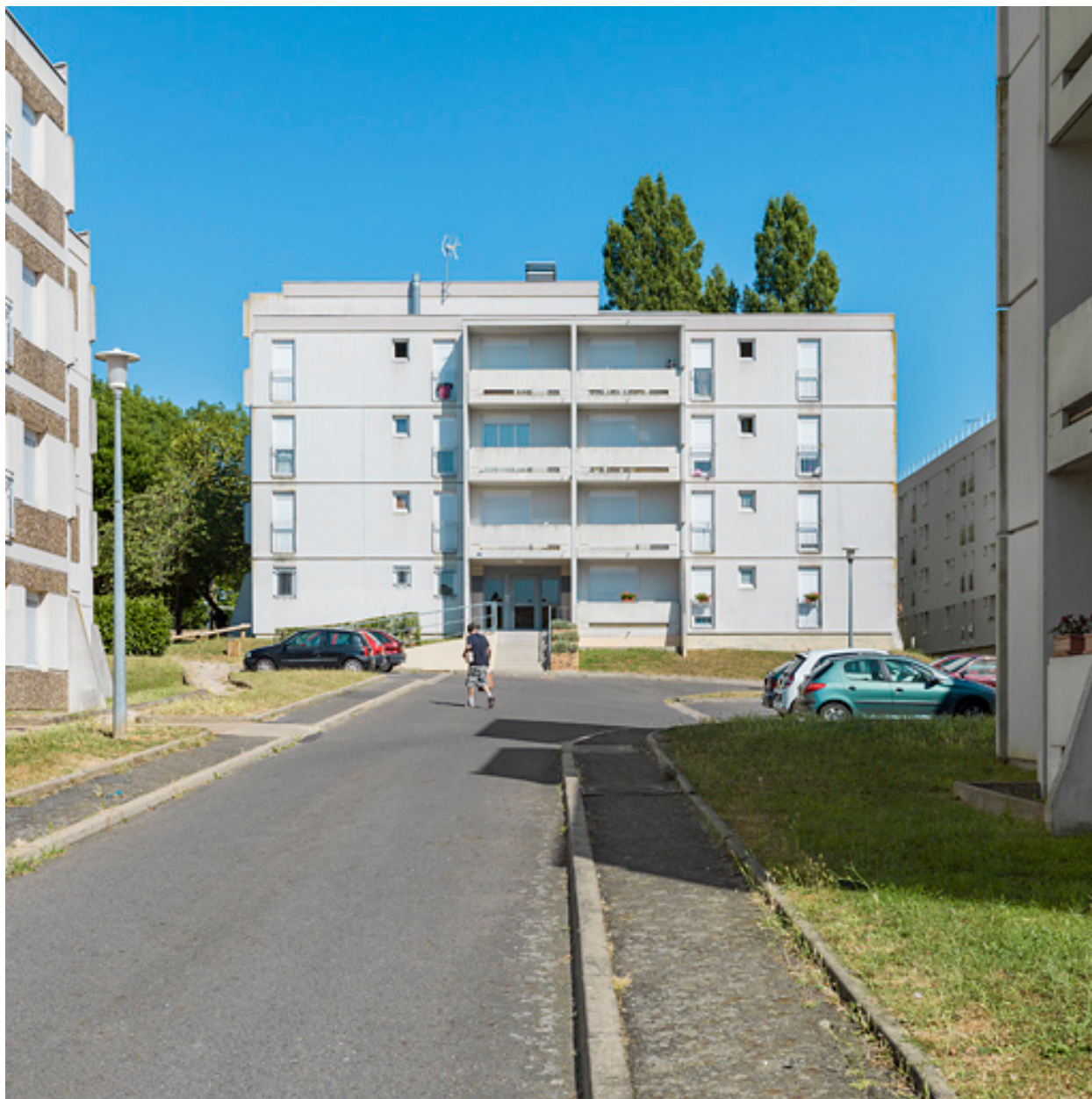
Bâtiment 27, façade antérieure ouest.
