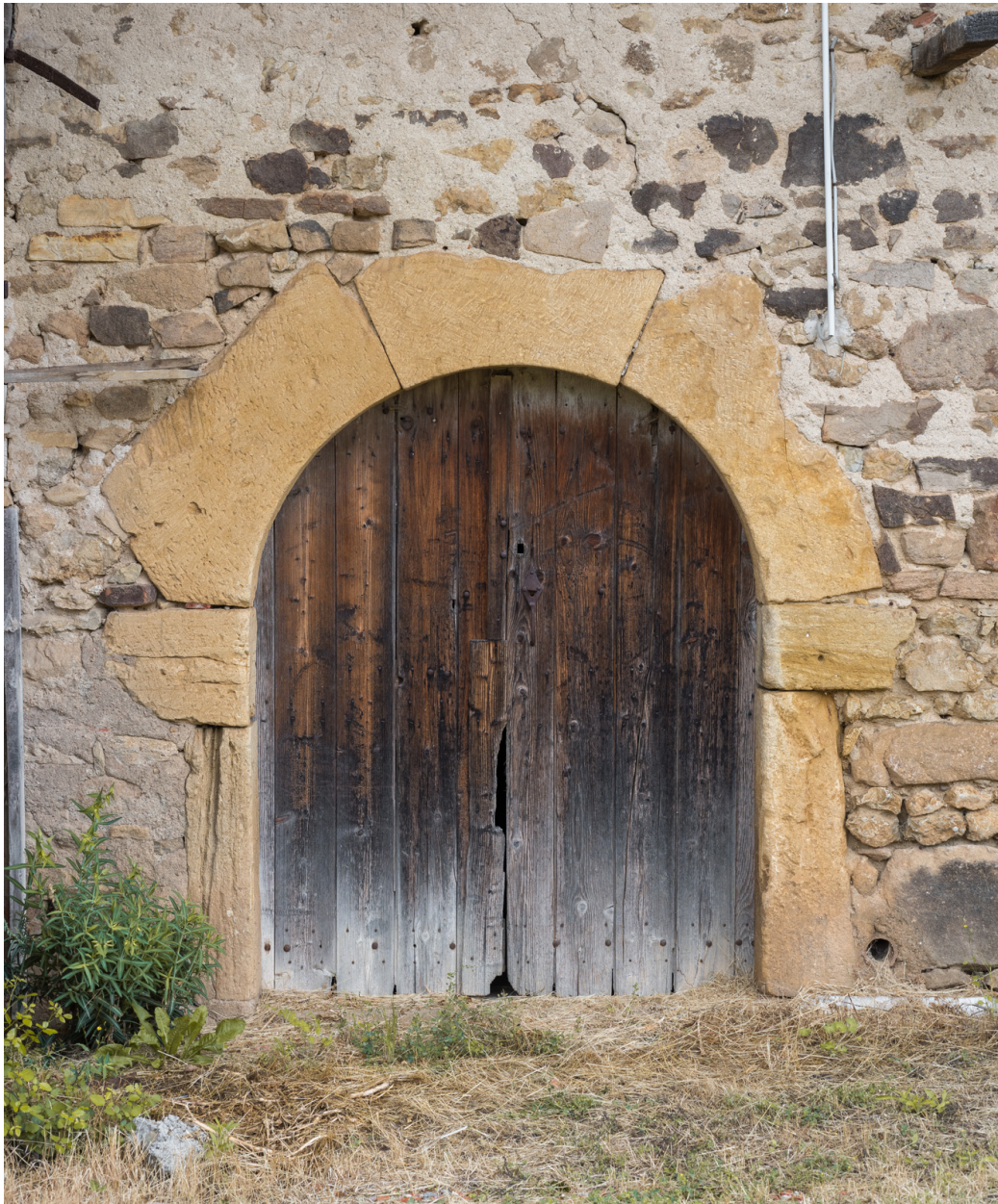
Détail de la façade antérieure de la grange : porte de l'étable double, à gauche de la remise.
