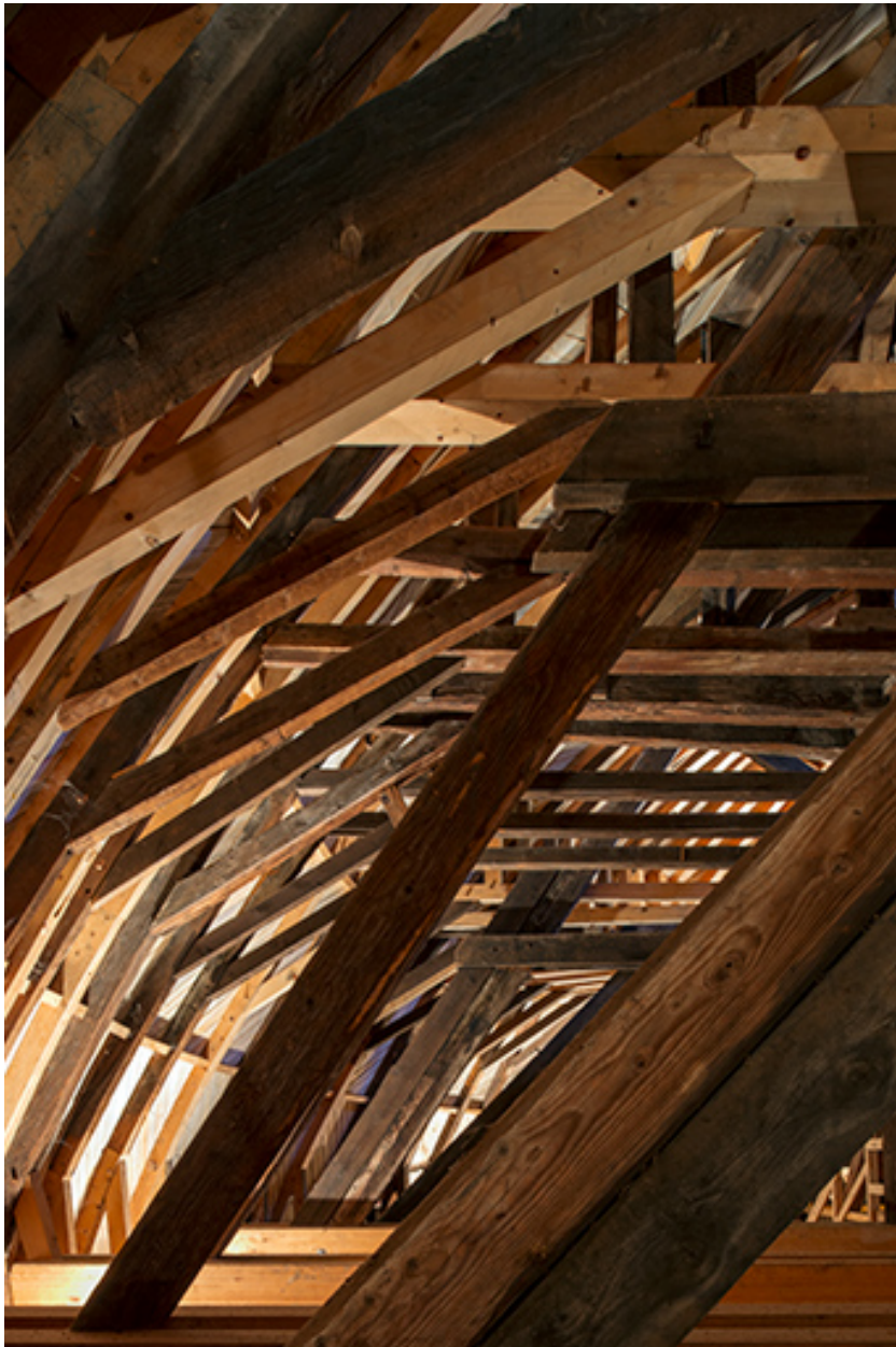
Côté sud de la charpente du dôme.
