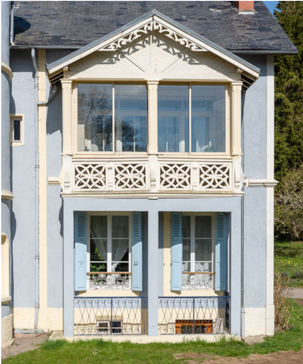
Façade sud-est, oriel.
