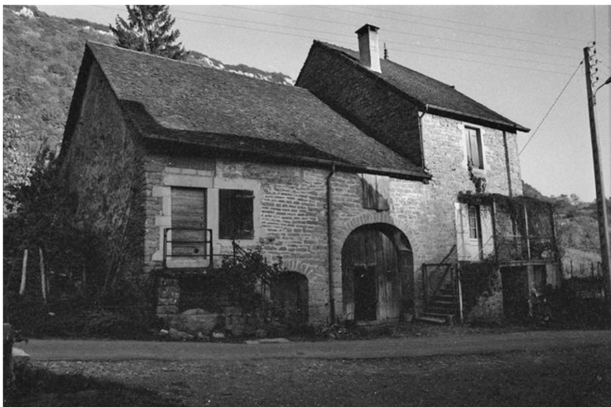
Maison cadastrée 1965 AD 105 : façade sud.
