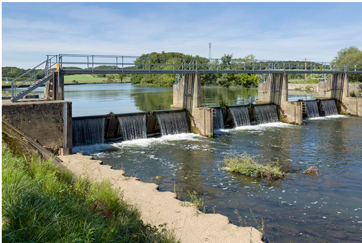
Le barrage à clapets.
