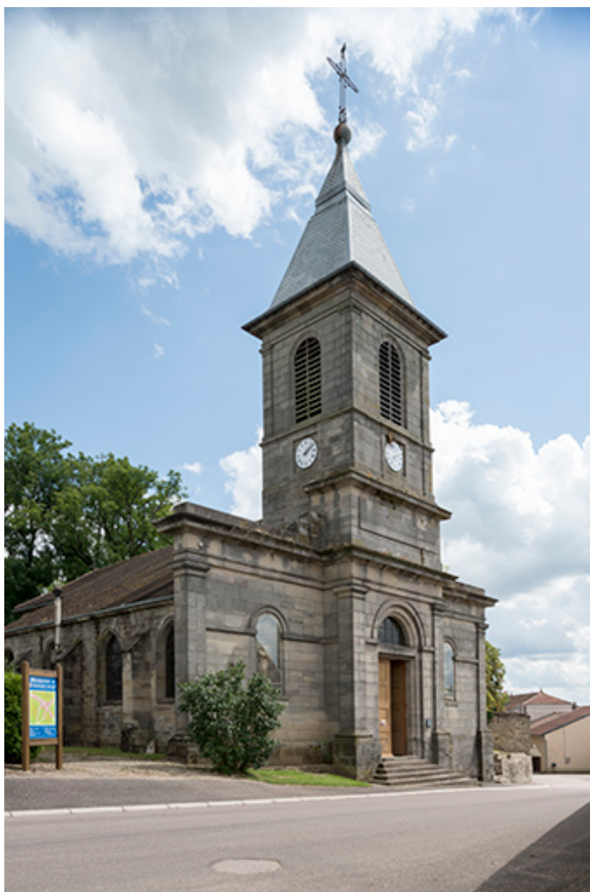
Vue de trois-quart nord.
