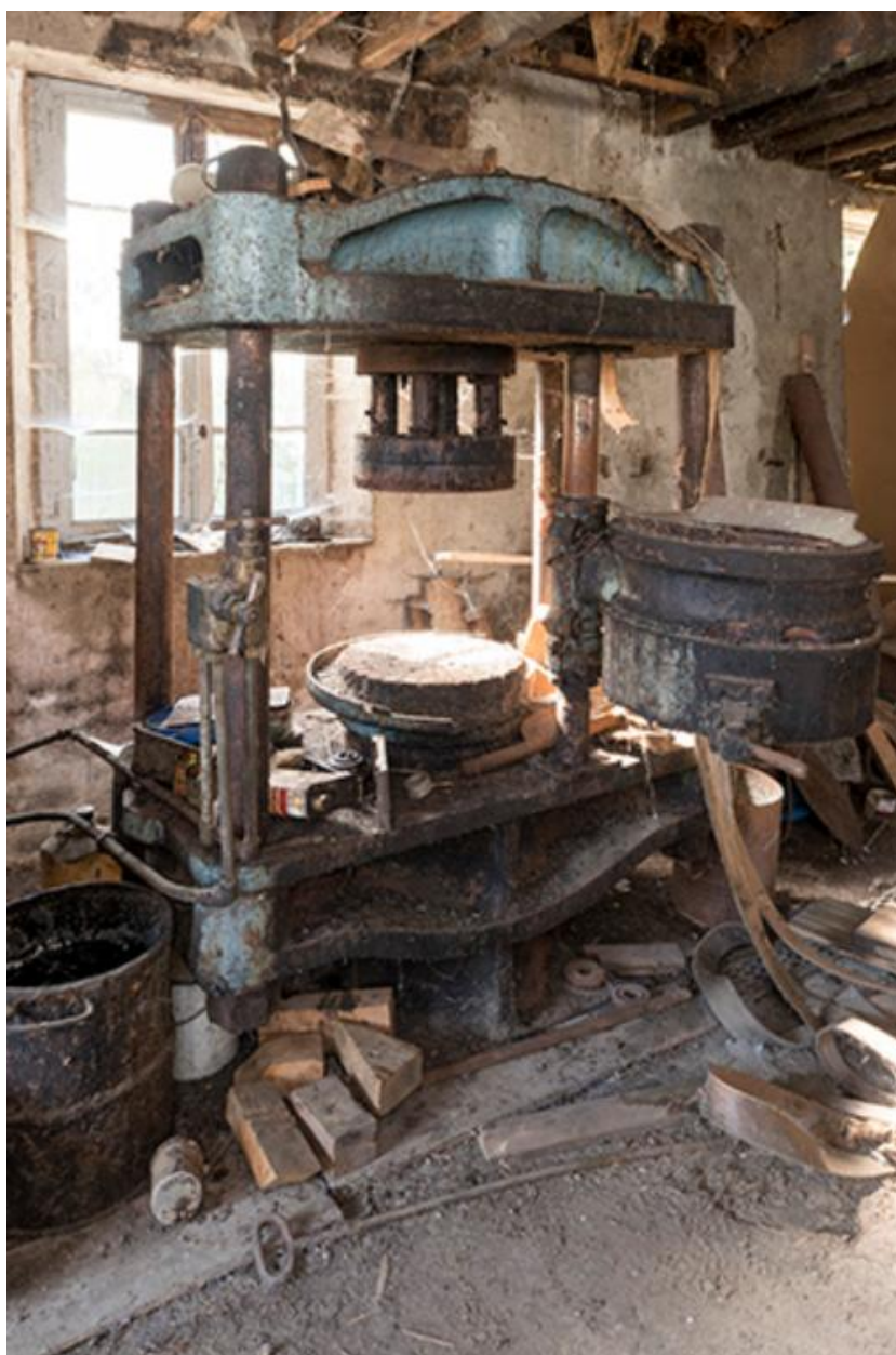
machine du rez-de-chaussée: presse hydraulique
