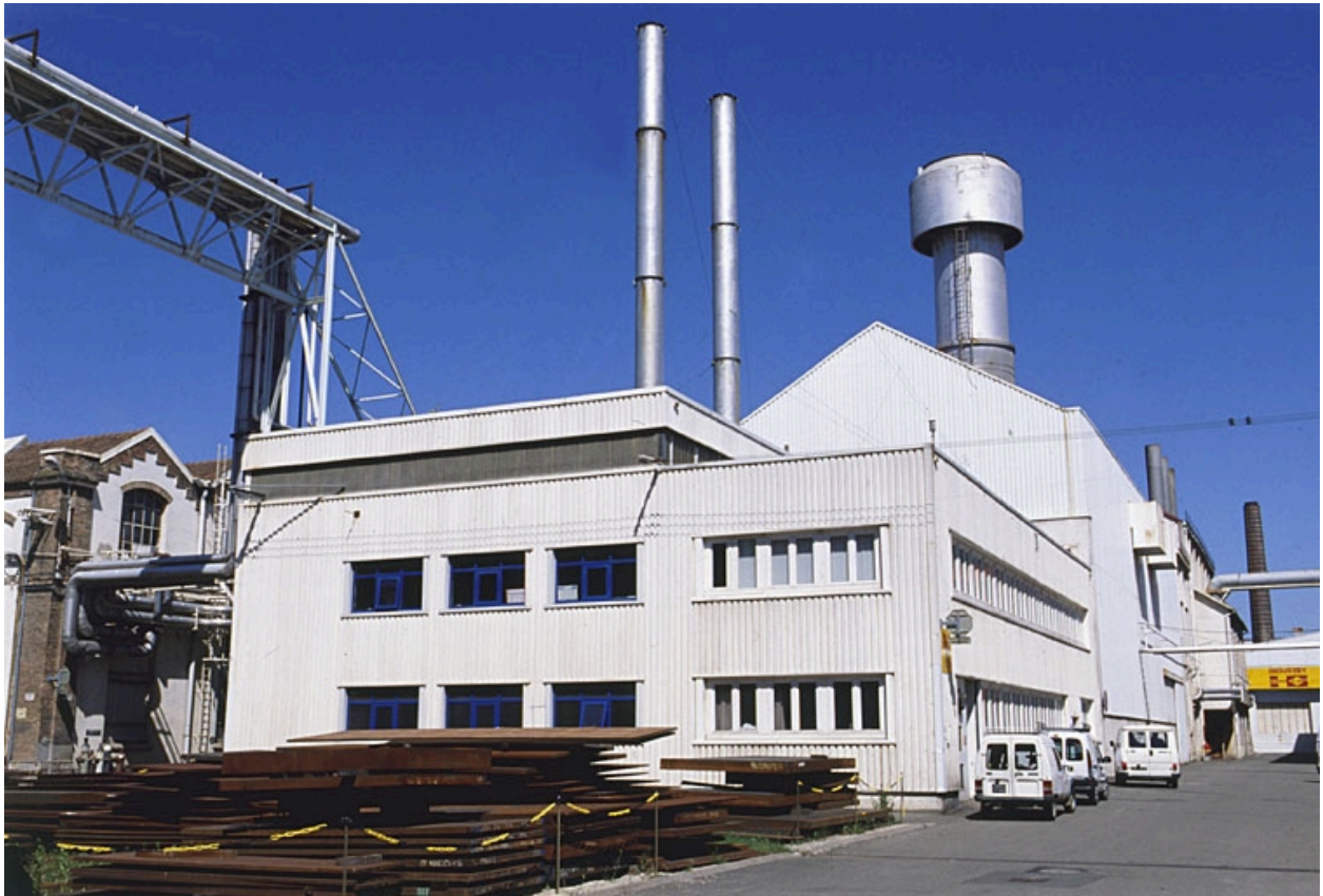
Bâtiment sur l'avenue 3 (ancienne station centrale ?).
