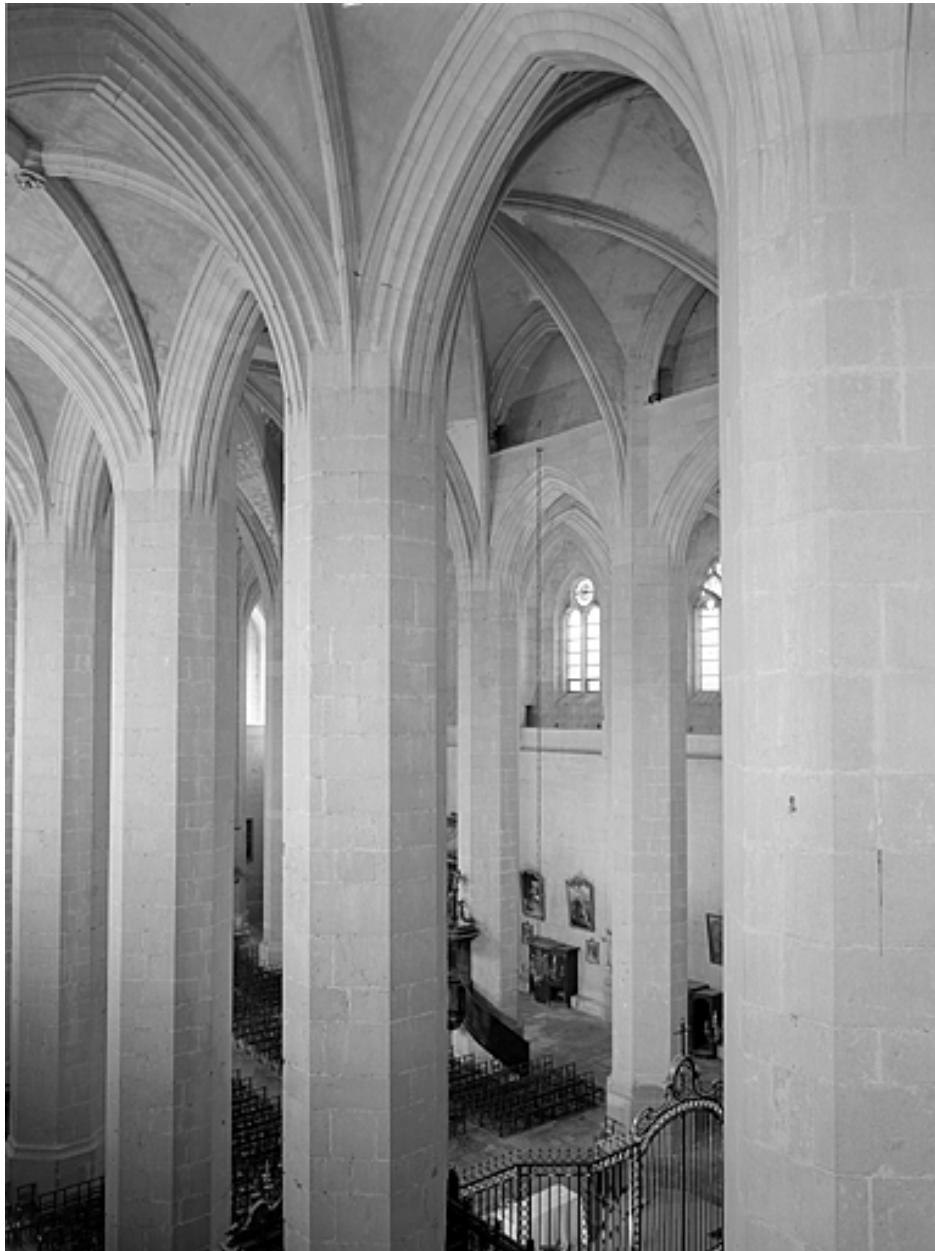
Elévation nord-ouest de la nef depuis la coursière basse.
