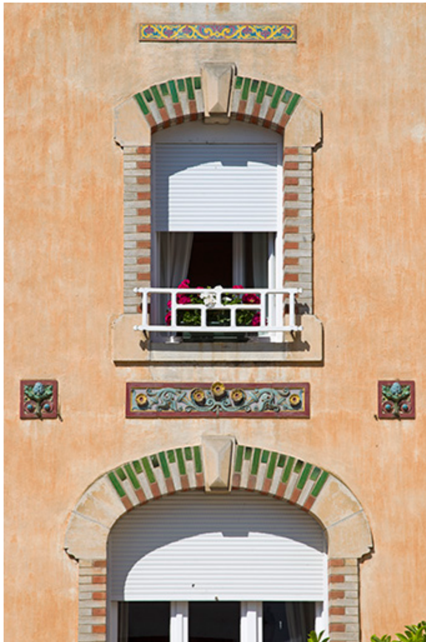
Détail de baies de l'avant-corps.
