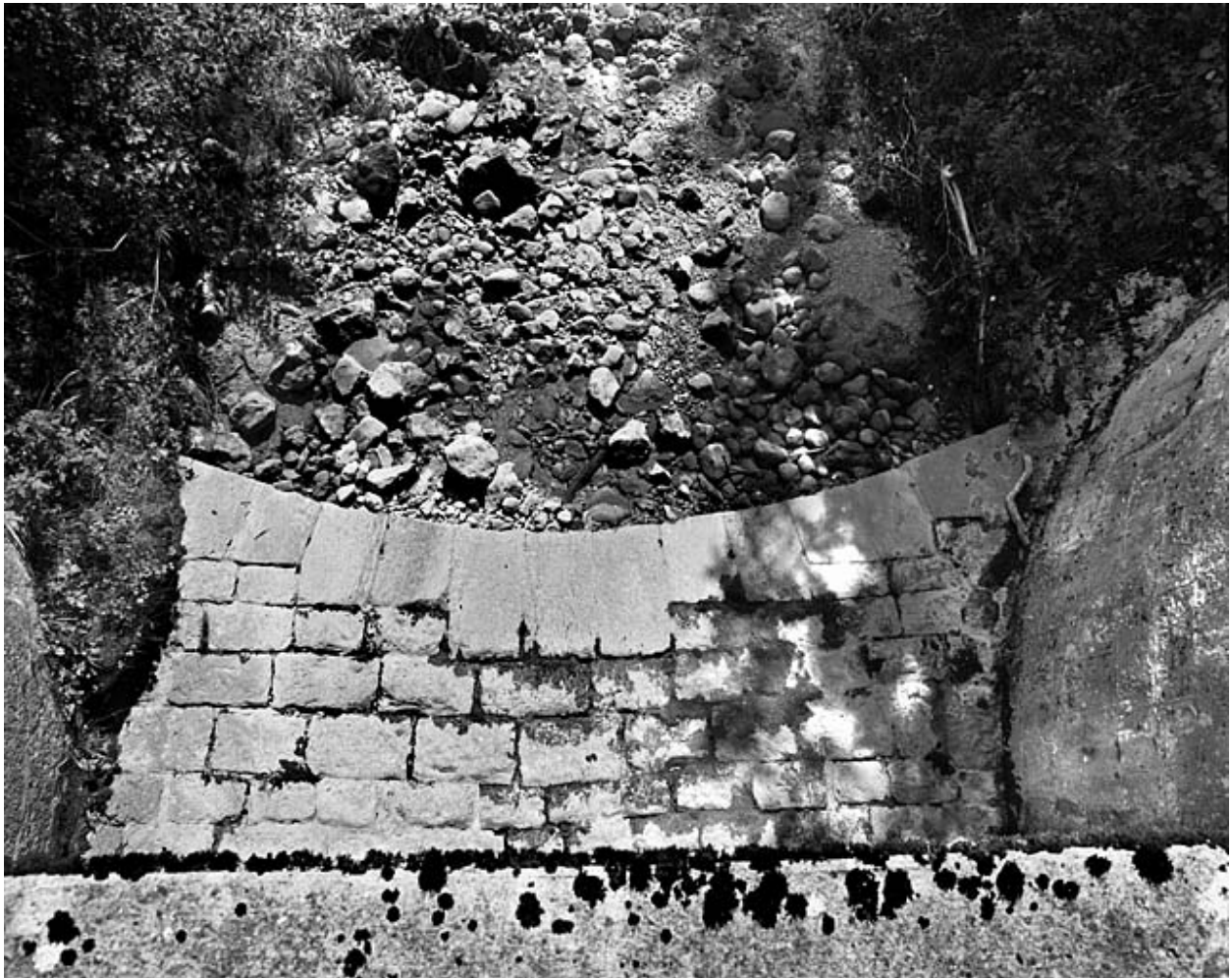
Pont : vue plongeante sur le radier aval.
