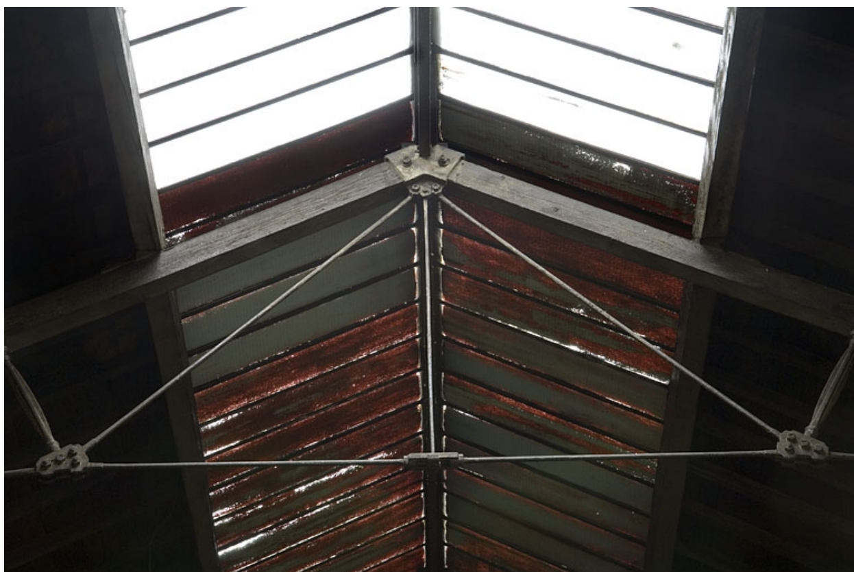
Détail de la charpente Polonceau de l'atelier.
