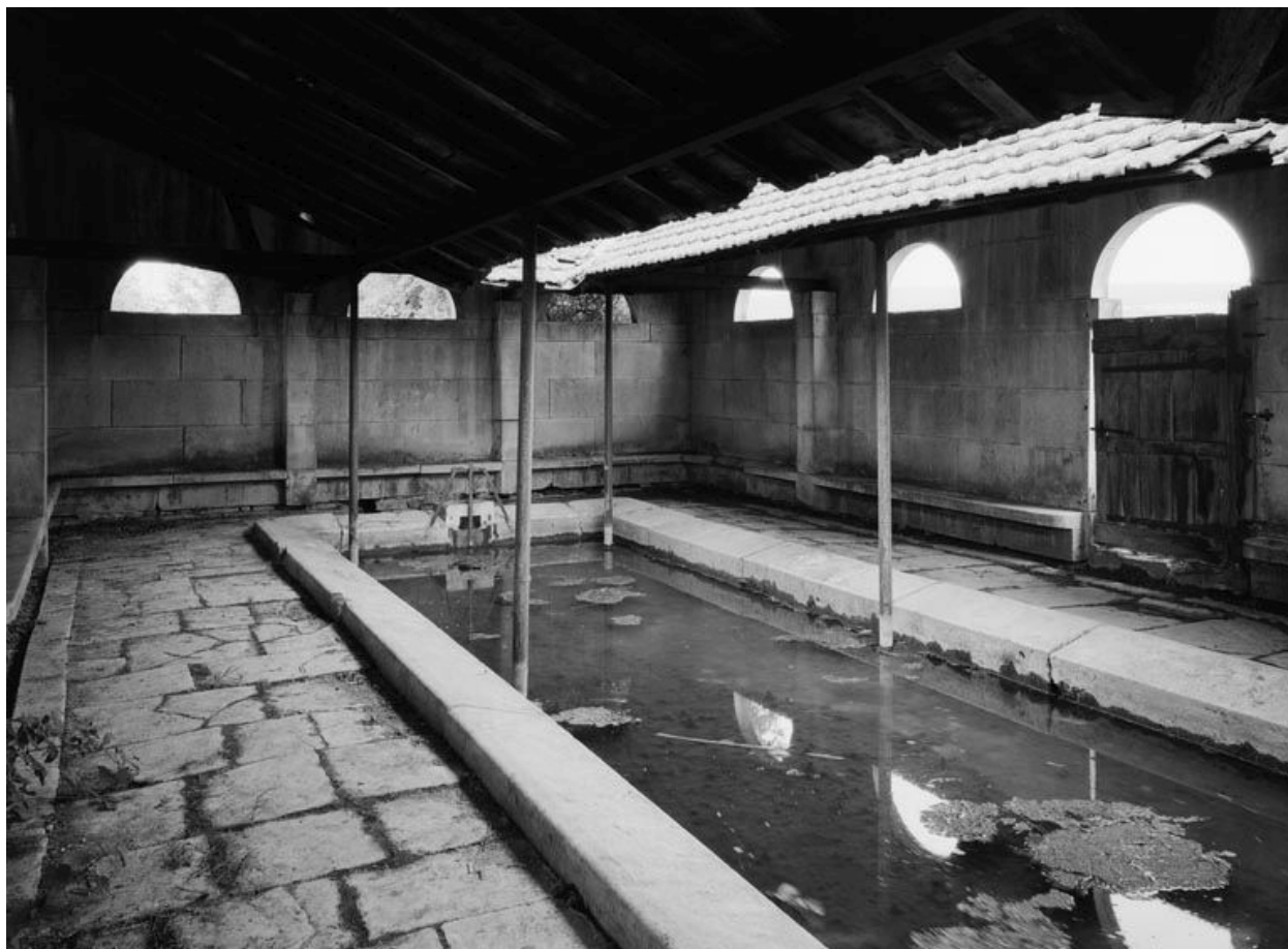
Vue intérieure du lavoir.
