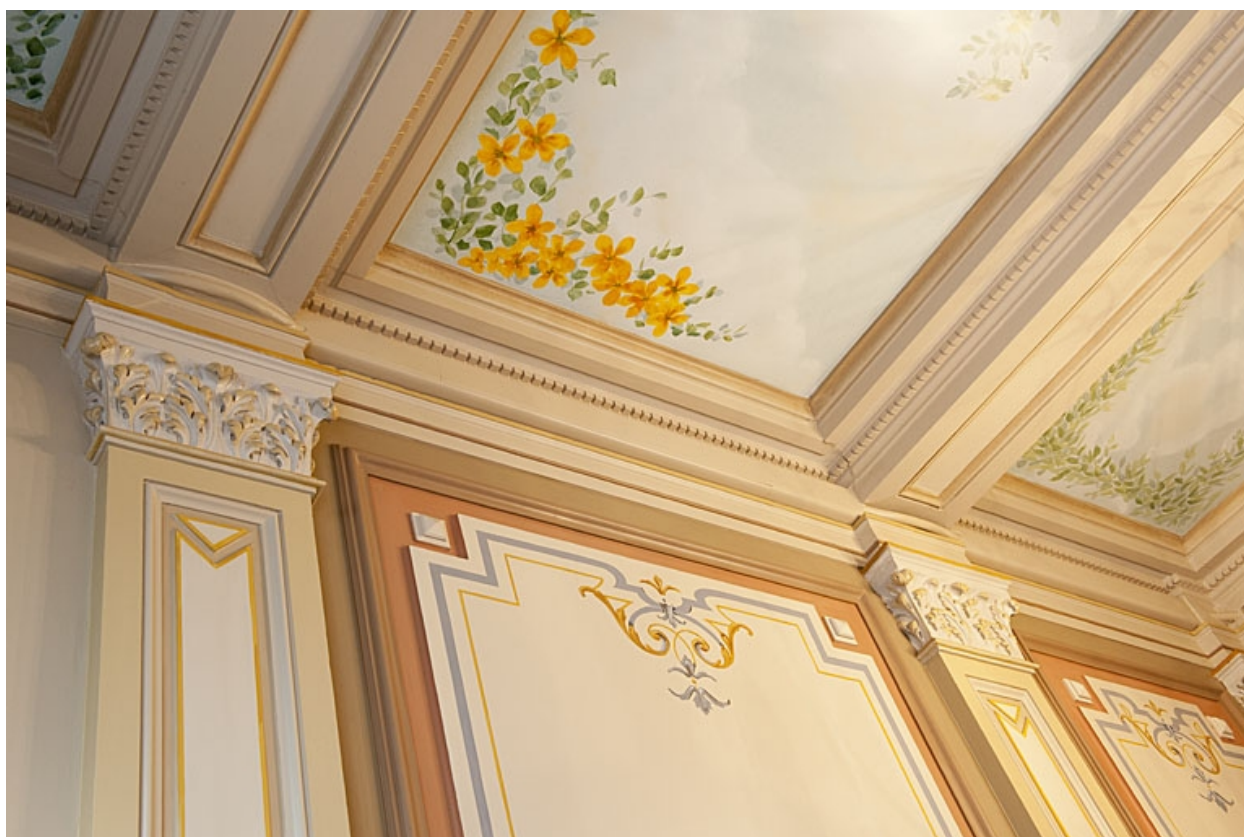
Détail du décor du plafond et d'un panneau.
