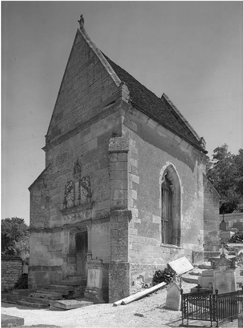
Façade antérieure et façade latérale droite.
