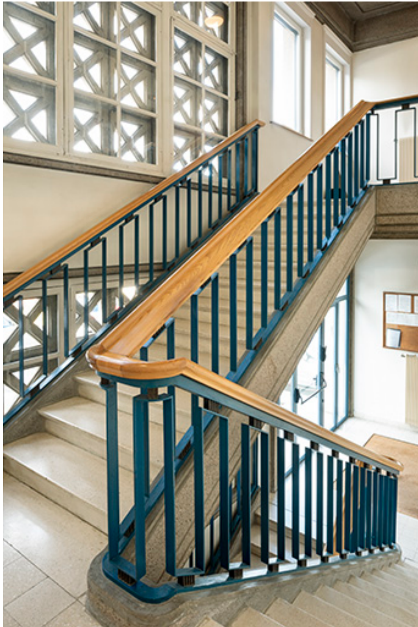
Rez-de-chaussée, corps oriental : escalier, depuis le repos.
