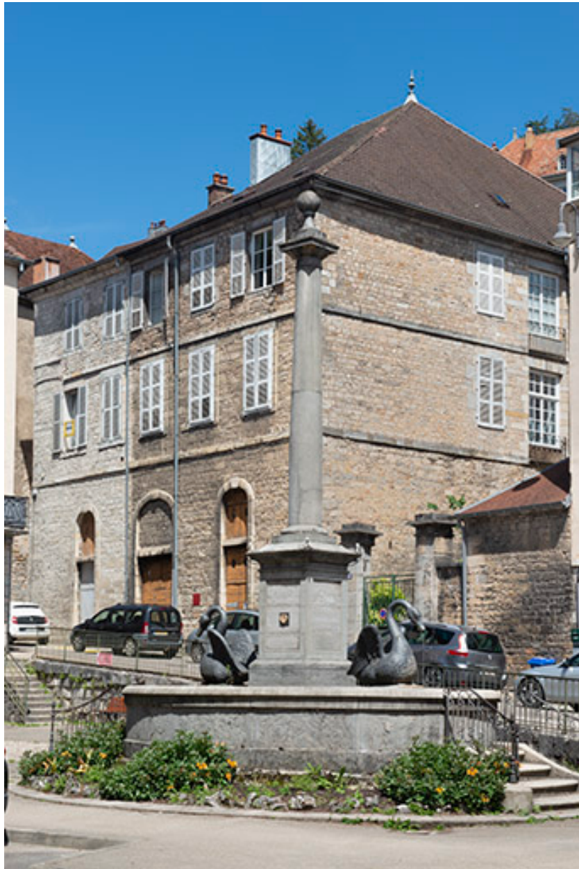
Vue rapprochée depuis le sud-ouest.
