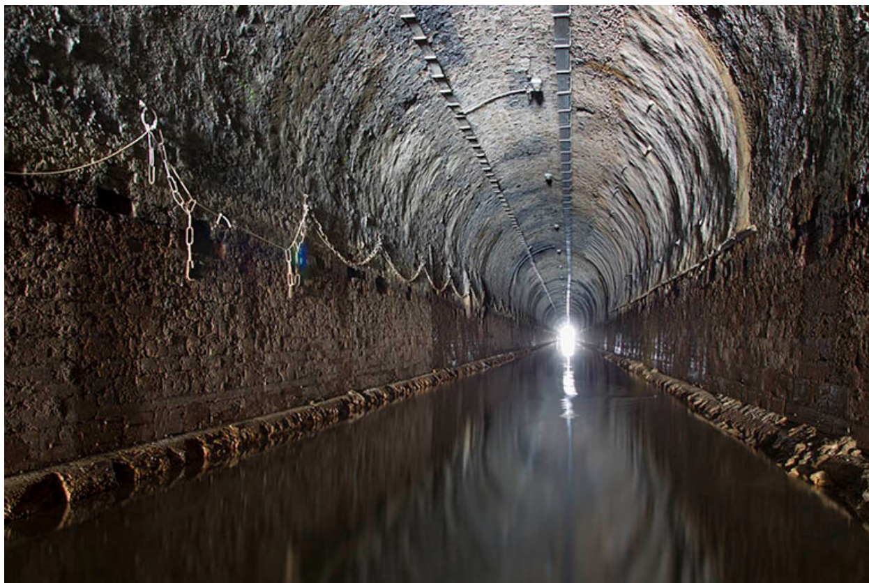
Intérieur du tunnel, vue générale.
