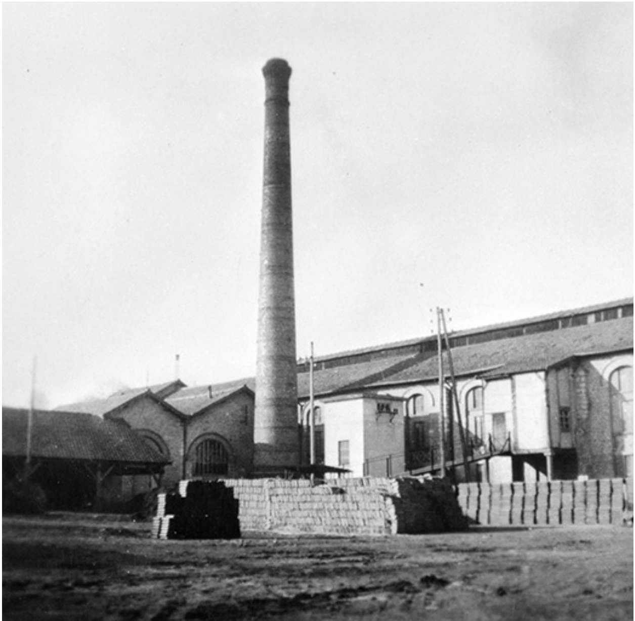
Ateliers et cheminée vus du nord.
