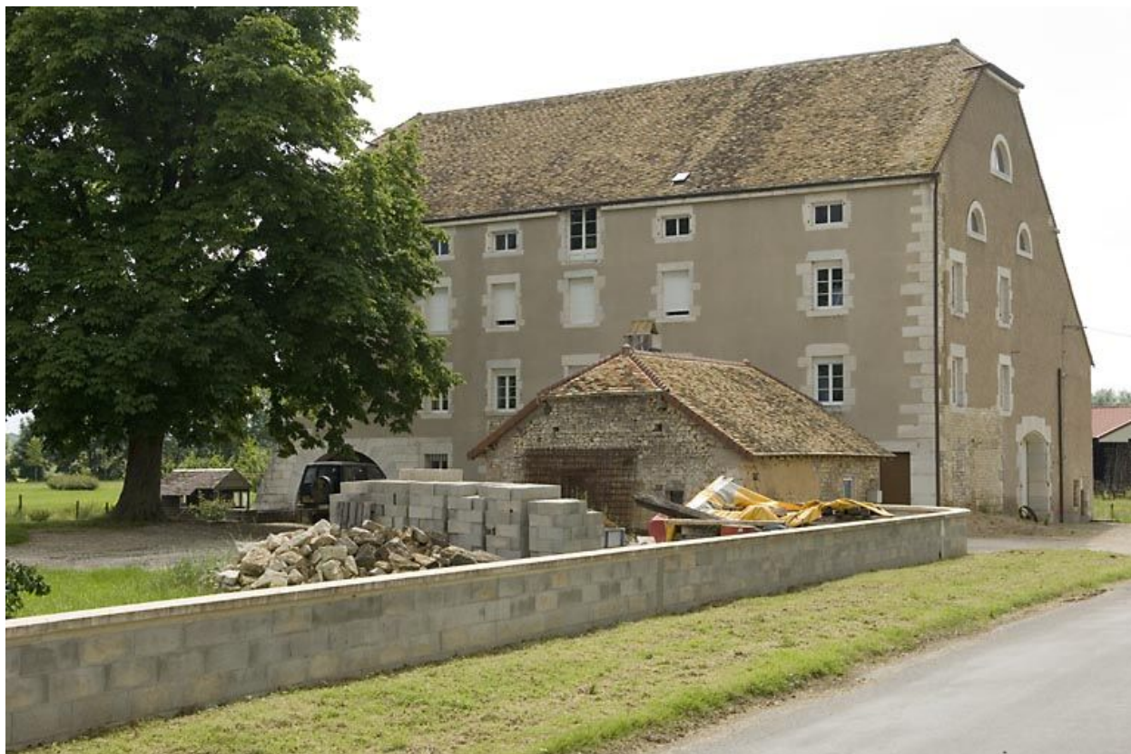
Vue du moulin depuis le nord-est.
