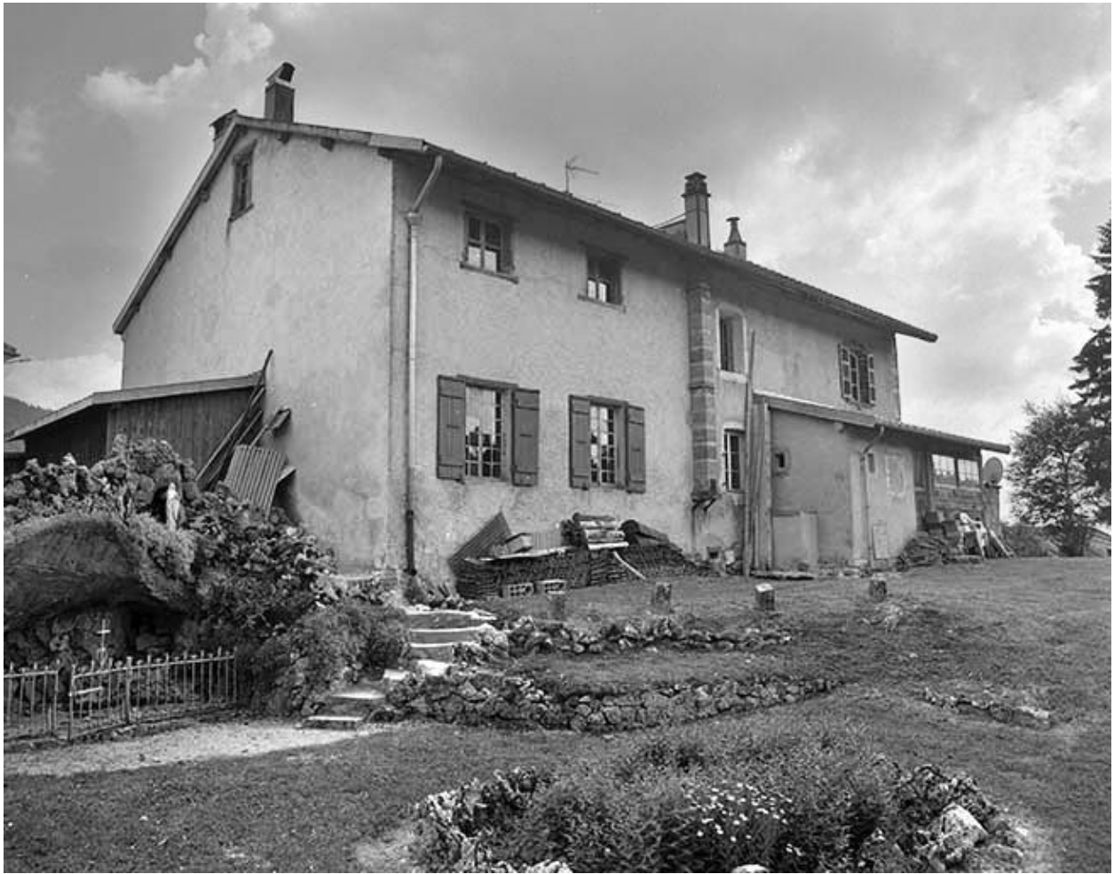
Façade postérieure et face droite.
