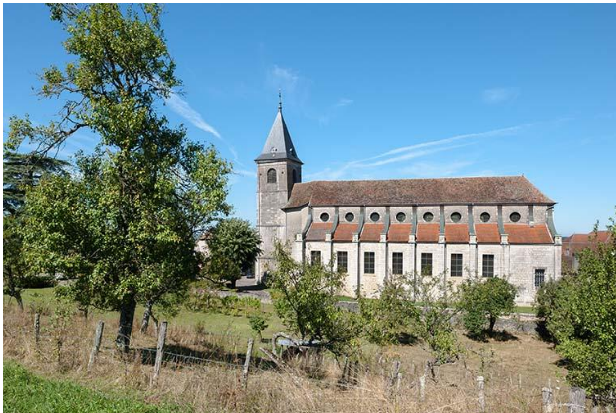
Vue générale sud de l'église
