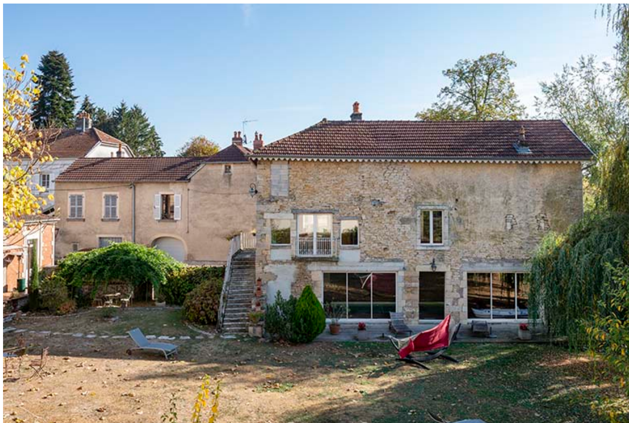
L'ancien bâtiment à usage de tannerie.
