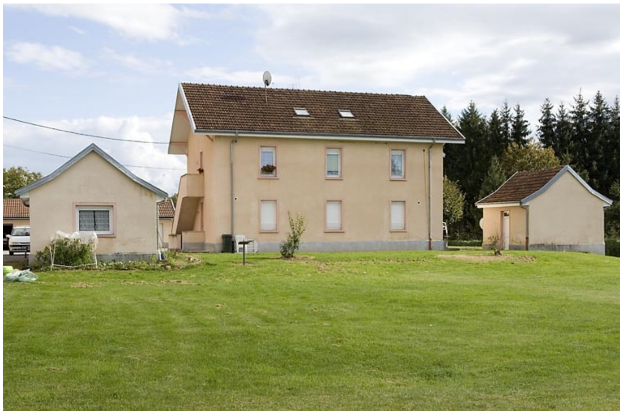
Logement ouvrier. Façade depuis la route.
