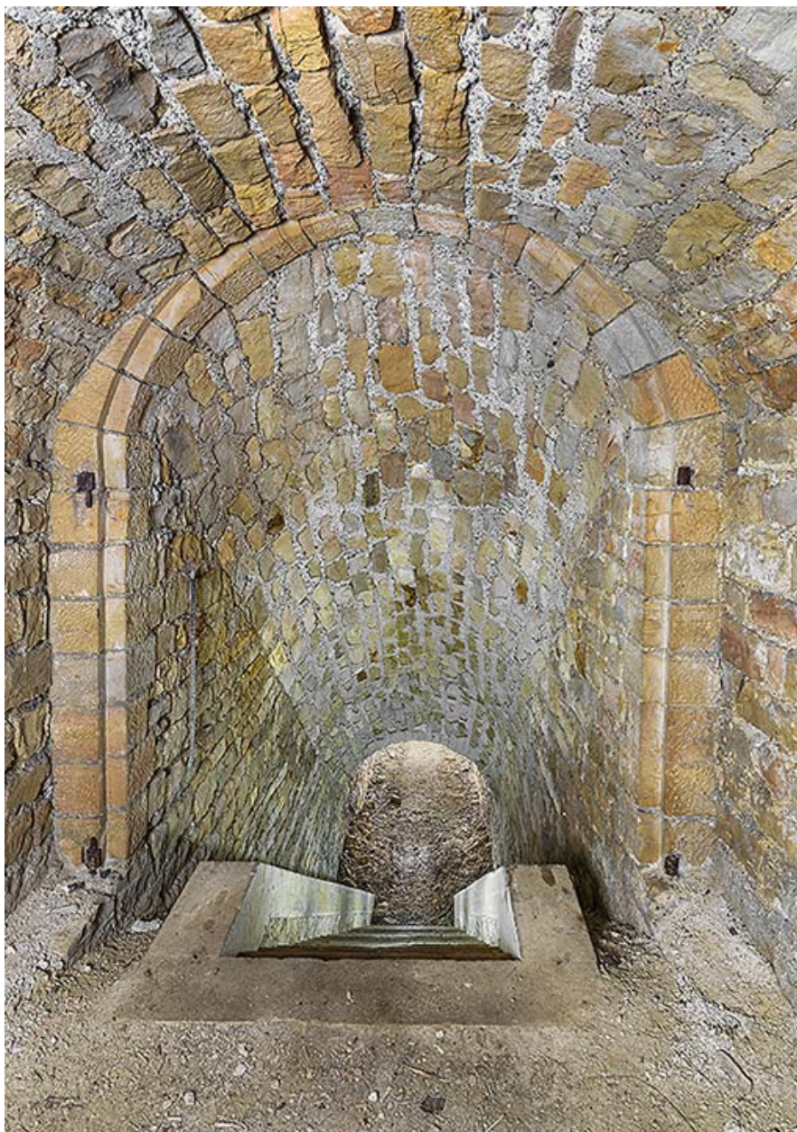
Rampe-escalier vers la double caponnière.
