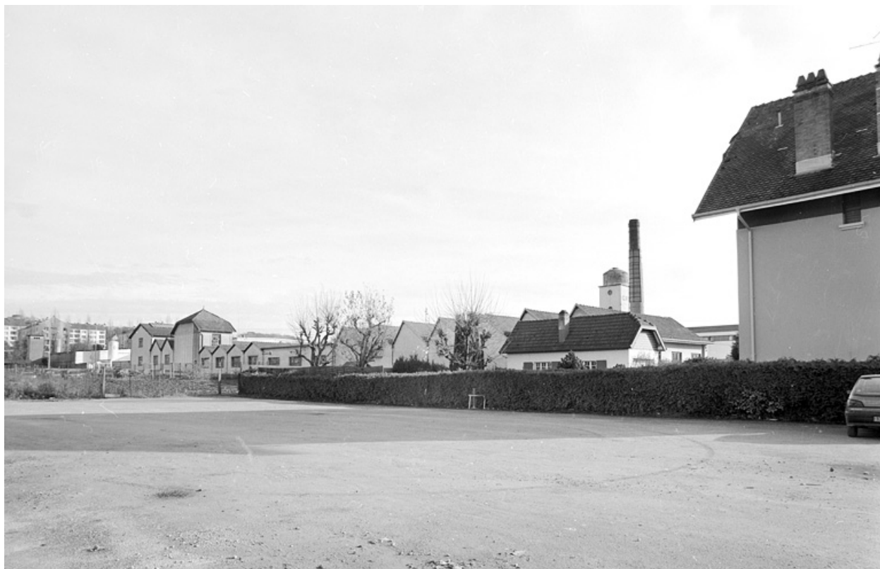
Murs-pignons nord de l'usine.
