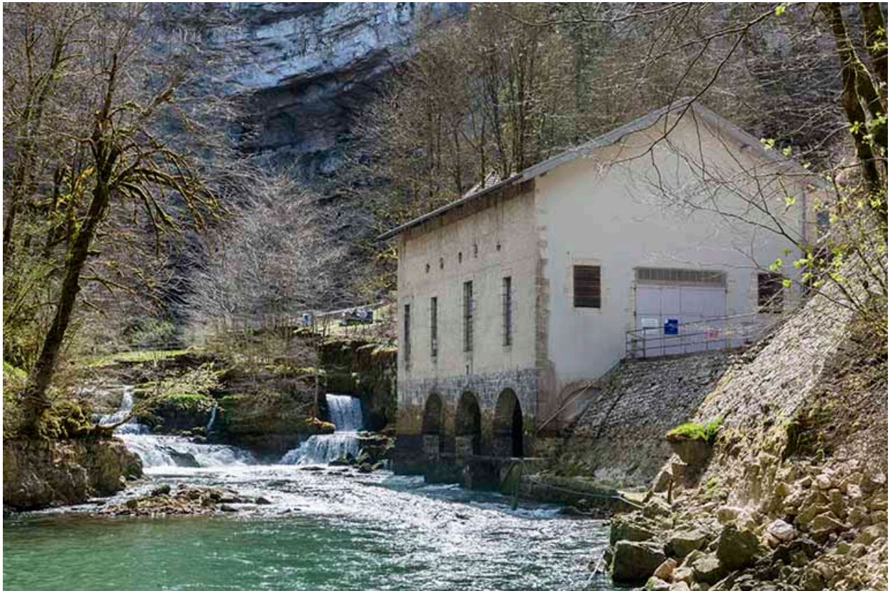
Façade sur la Loue de la centrale hydroélectrique.
