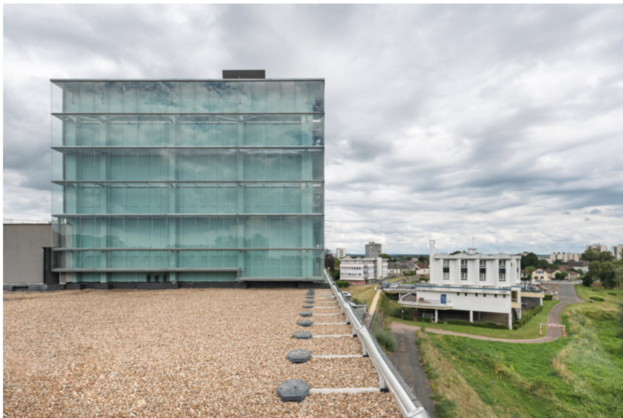
Maison de la culture : cage de scène, vue depuis le toit.
