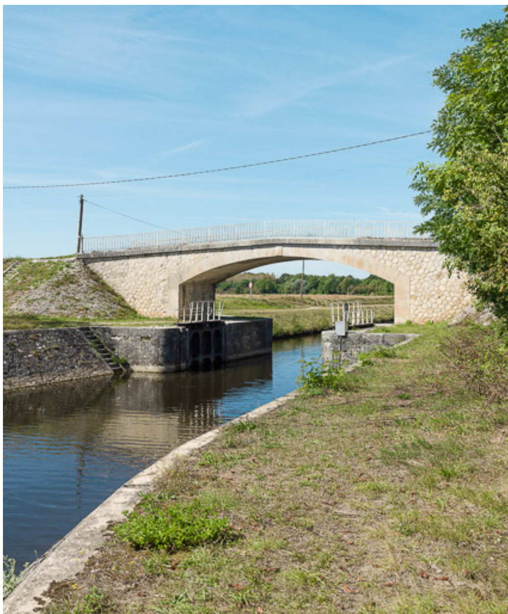
Vue d'ensemble du pont.
