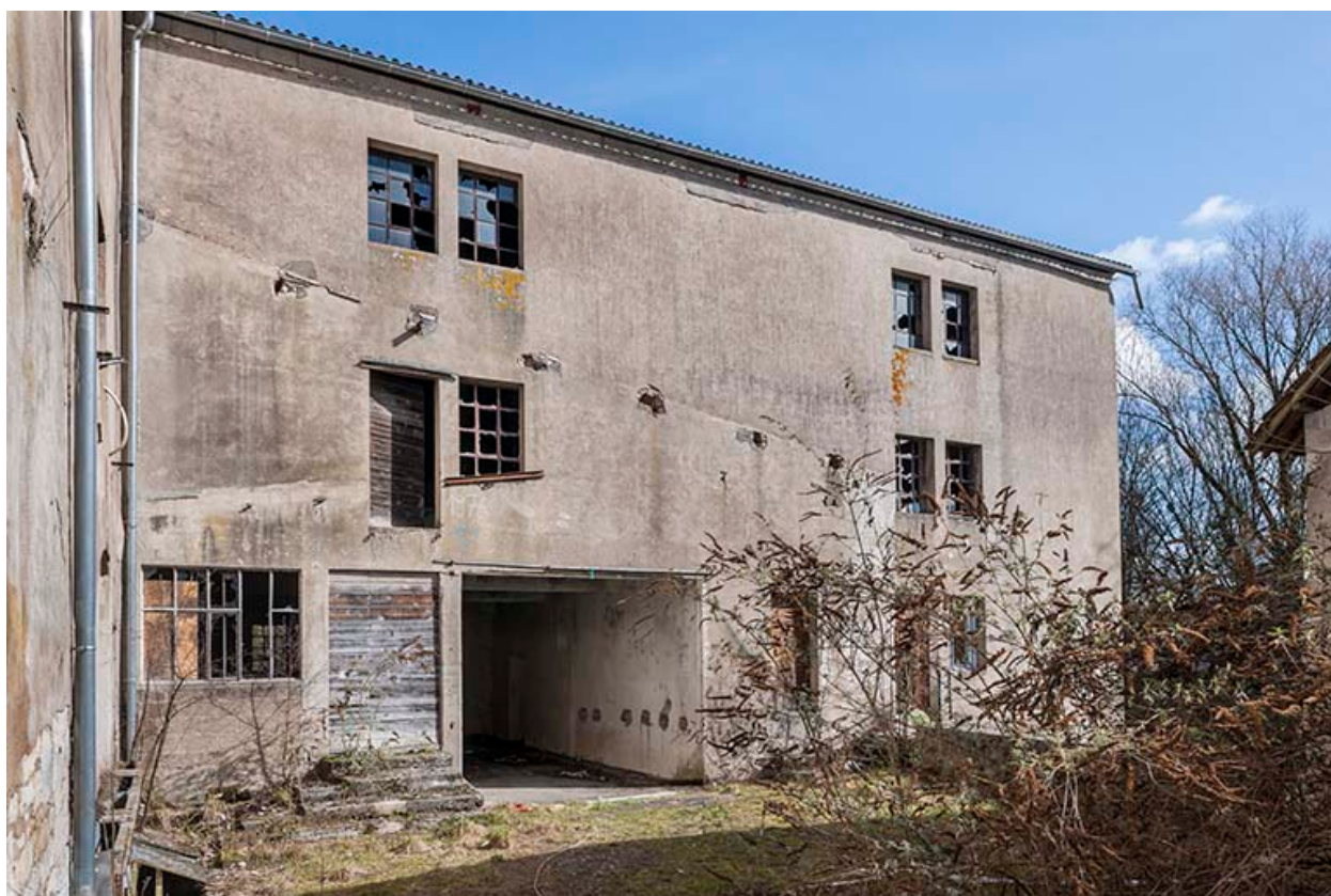
Façade sud du magasin industriel.
