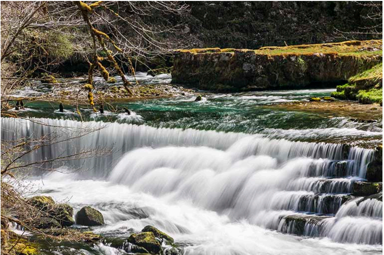
Le barrage du moulin dessous.
