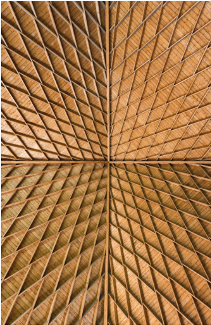
Charpente. Vue en contre-plongée.
