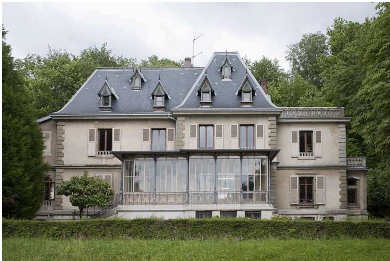
Façade antérieure depuis l'ouest.
