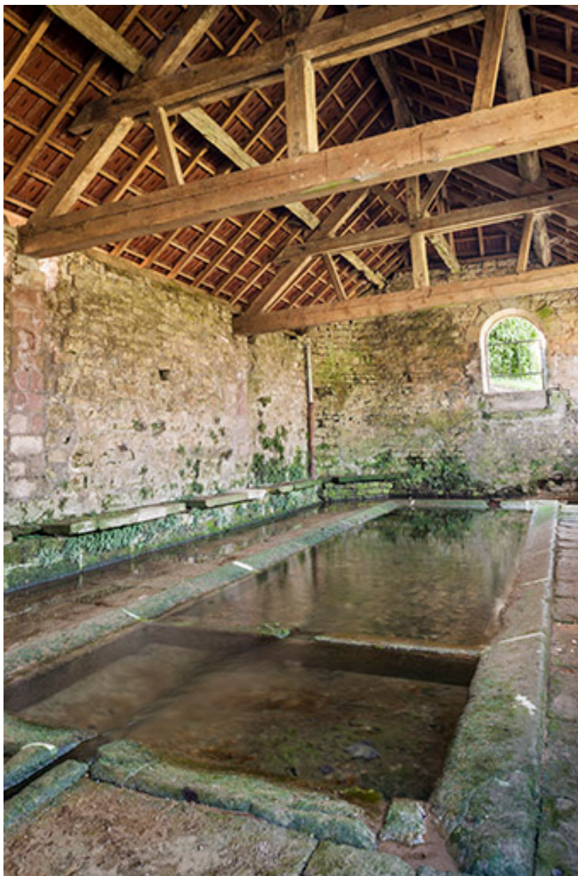
Vue générale des bassins.
