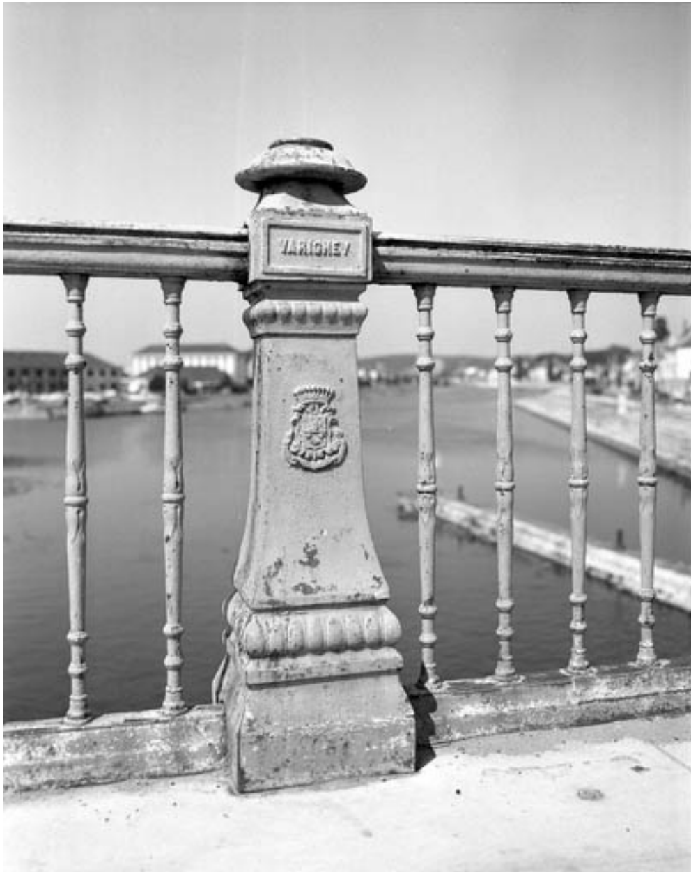
Détail du garde-corps : vue du balustre central.
