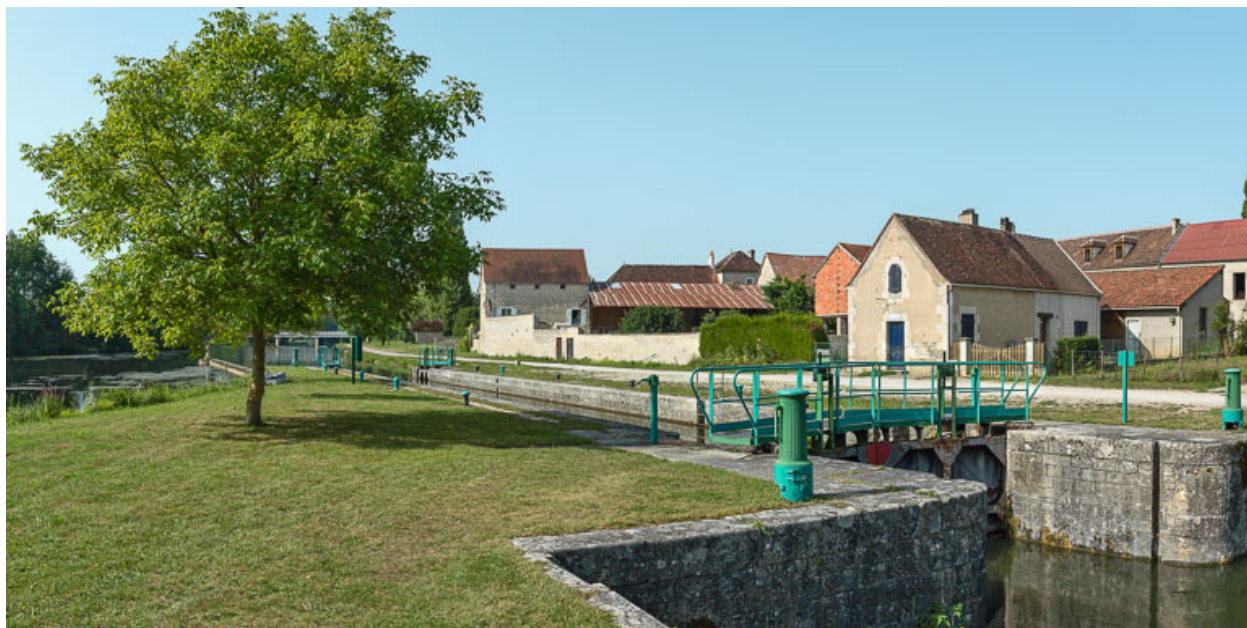
Vue du site d'écluse.
