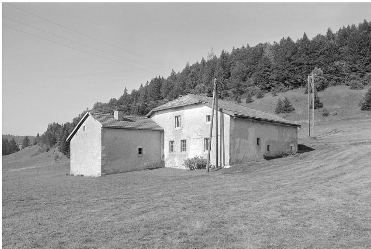
Face sud-est et façade postérieure.
