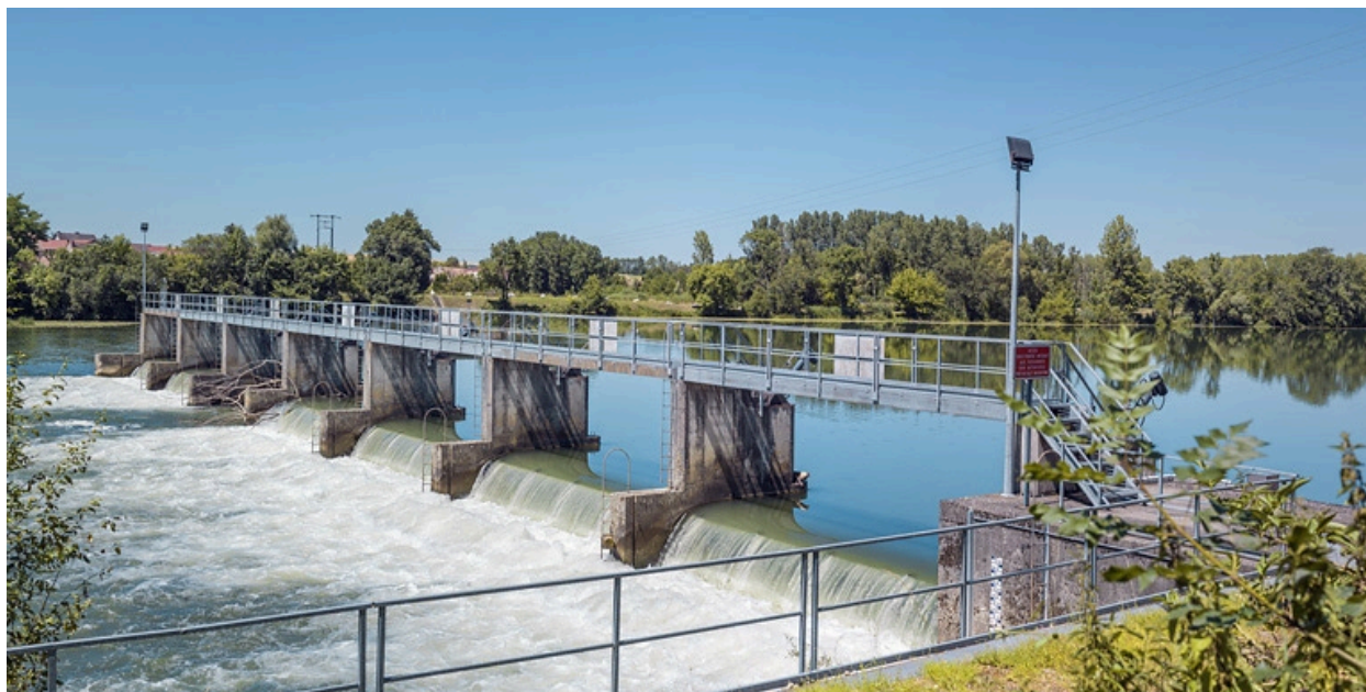
Barrage et ses vérins hydrauliques depuis la rive gauche.
