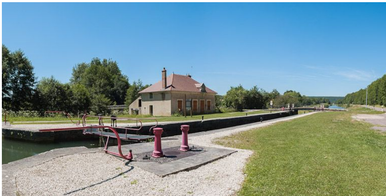
Le site d'écluse vu d'amont.
