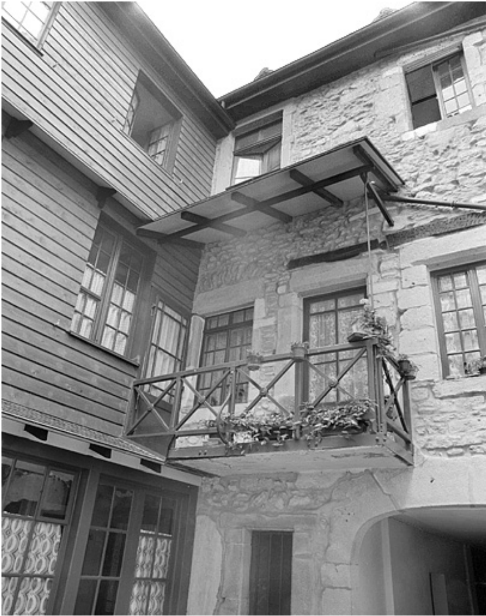
Façade sur cour du premier corps de bâtiment et galerie de liaison à gauche.
