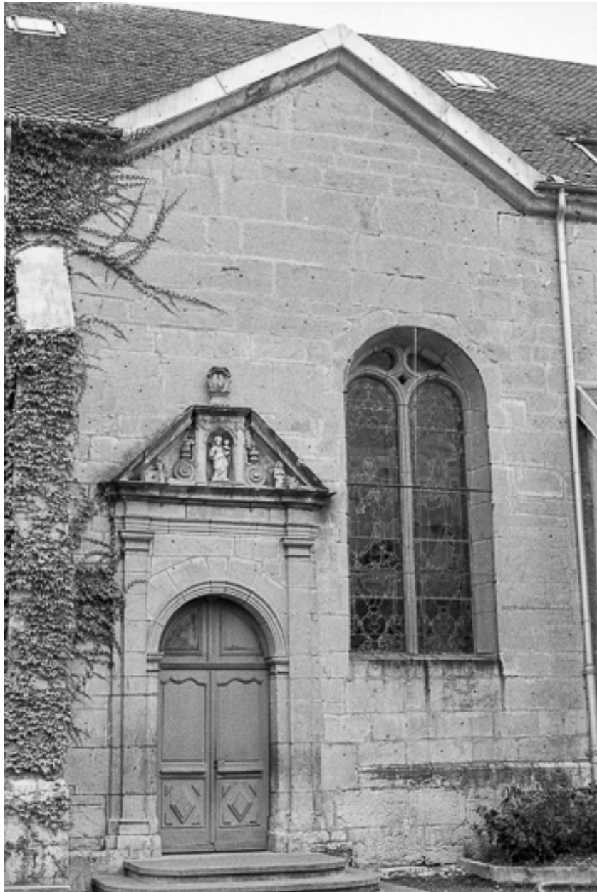
Face latérale gauche, troisième travée de la nef.
