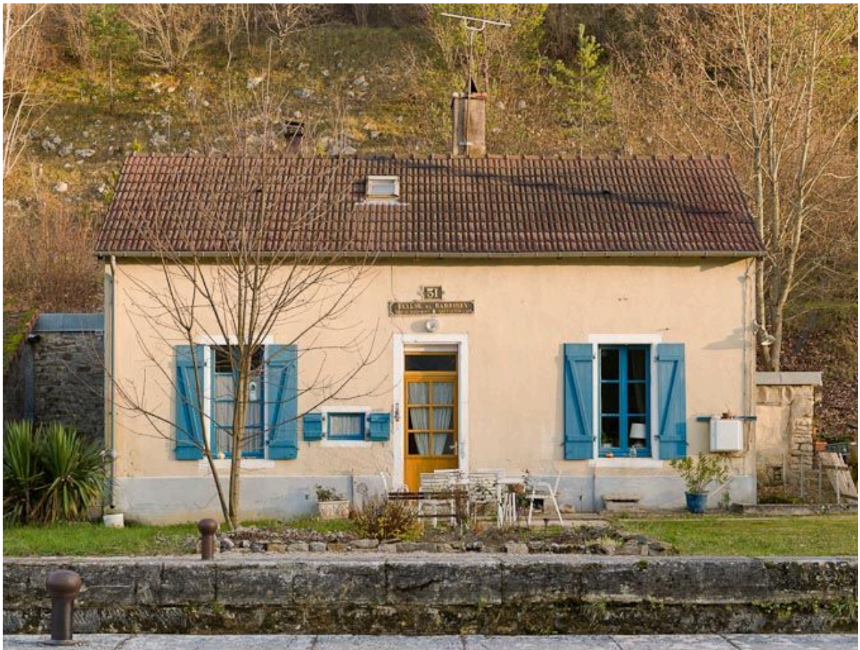
Vue de face de la maison éclusière.
