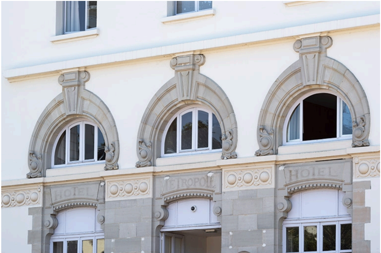
Façade nord, vue de trois quarts, détail.
